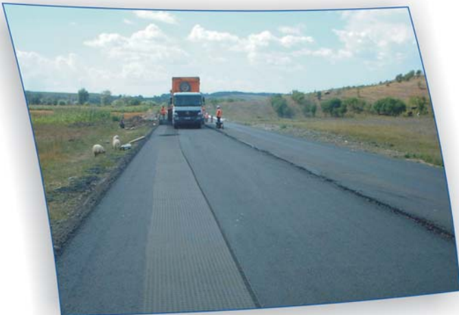
Armarea îmbrăcăminții asfaltice cu geocompozitul HaTelit C
