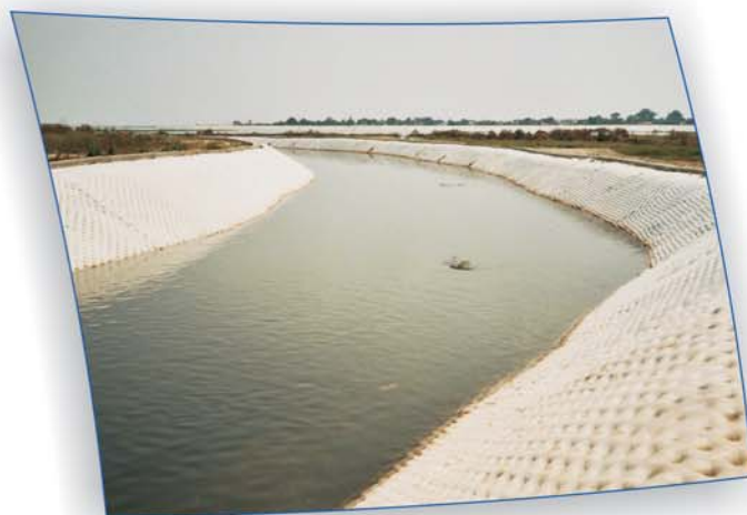
Apărare de mal Contra canal Frunzaru Proiectant: ISPH
