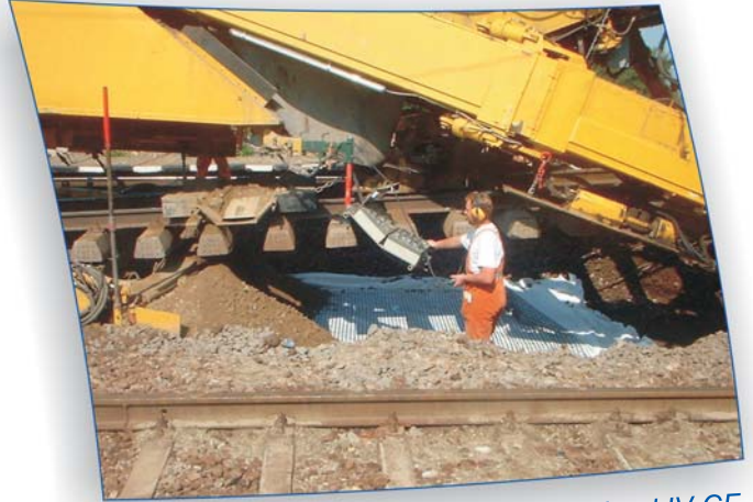
Stabilizare de terasamente cu geogrilă biaxială Fornit
