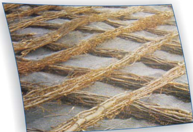
Protecție erozională Pod Giurgiu Proiectant: IPTANA Constructor: CCCF
