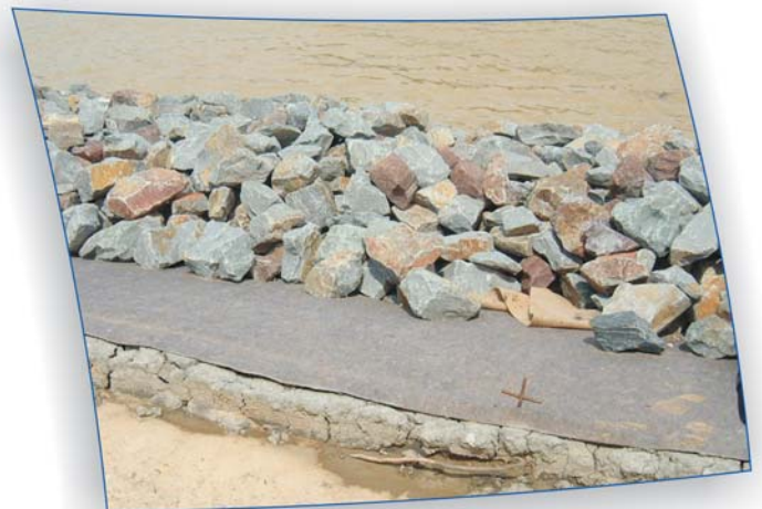
Strat de separare și filtrare realizat cu geotextilul HaTe
