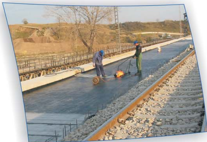
Coridorul IV CF Proiectant: ISPCF Consultanță: Transurb Constructor: CCCF
