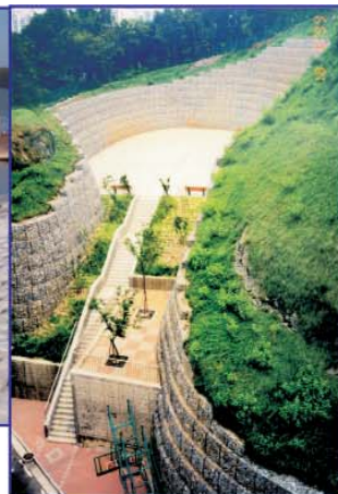
Structuri de sprijin din gabioane
