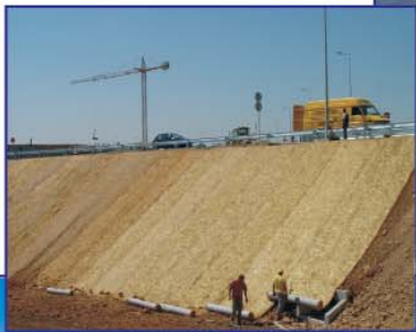
Protecție și înierbare cu saltele biodegradabile
