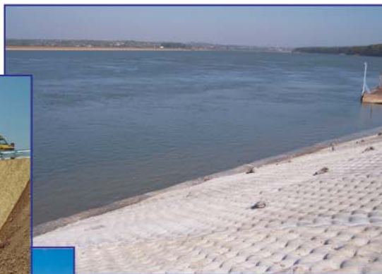
Protecție de mal cu saltele umplute cu beton
