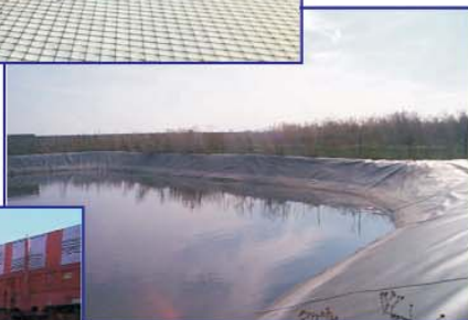
Bazin pentru depozitarea dejecțiilor: fermă de porci
