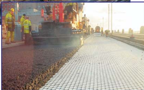
Ramforsarea îmbrăcăminții bituminoase
